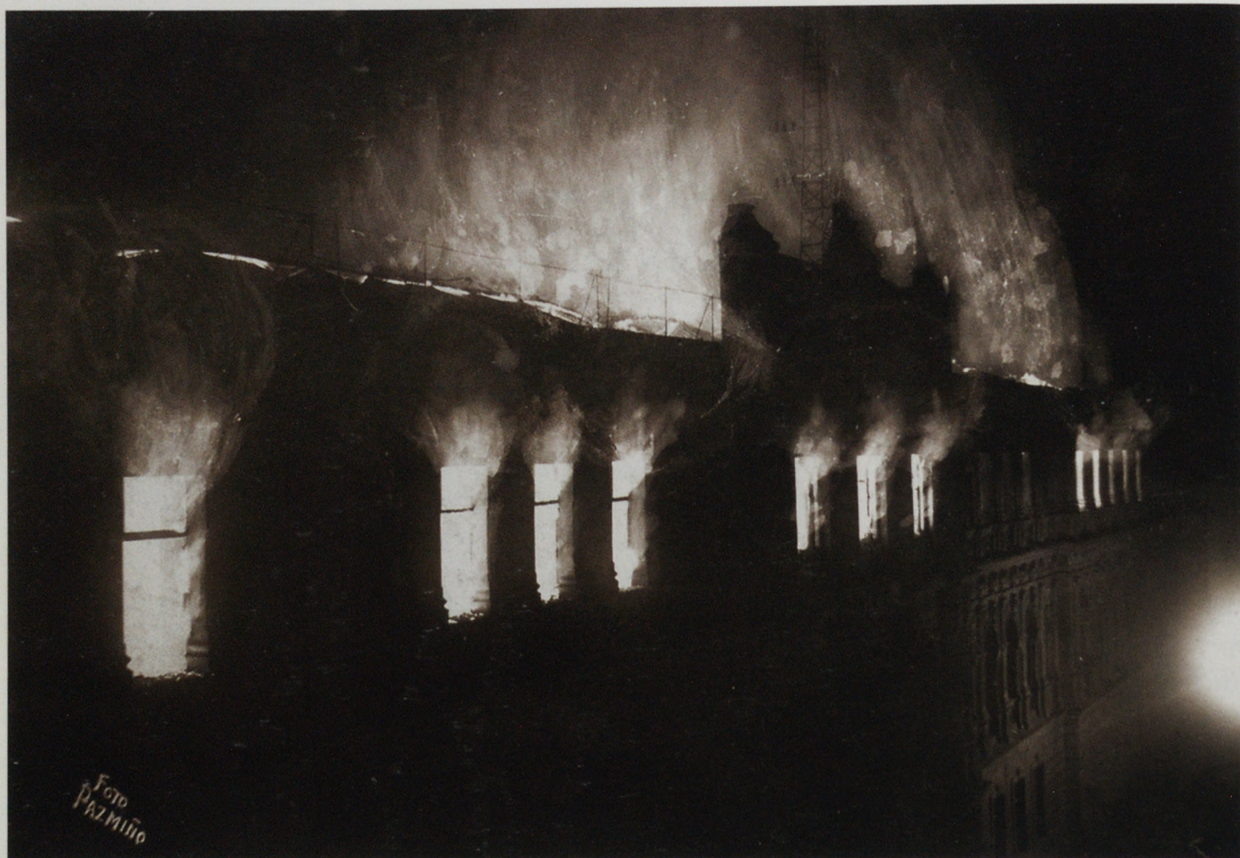
Incendio, en noviembre de 1929, del edificio de la Universidad Central del Ecuador, donde se reuniera el Congreso muchas veces desde el inicio de la República, así como en la década de 1950. AMDC.
